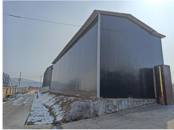
厂区北侧 乡村道路
