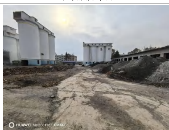
车间东南废弃筒仓
