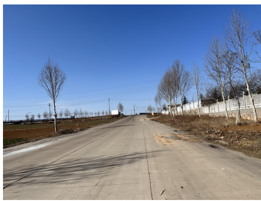
厂区门前道路
